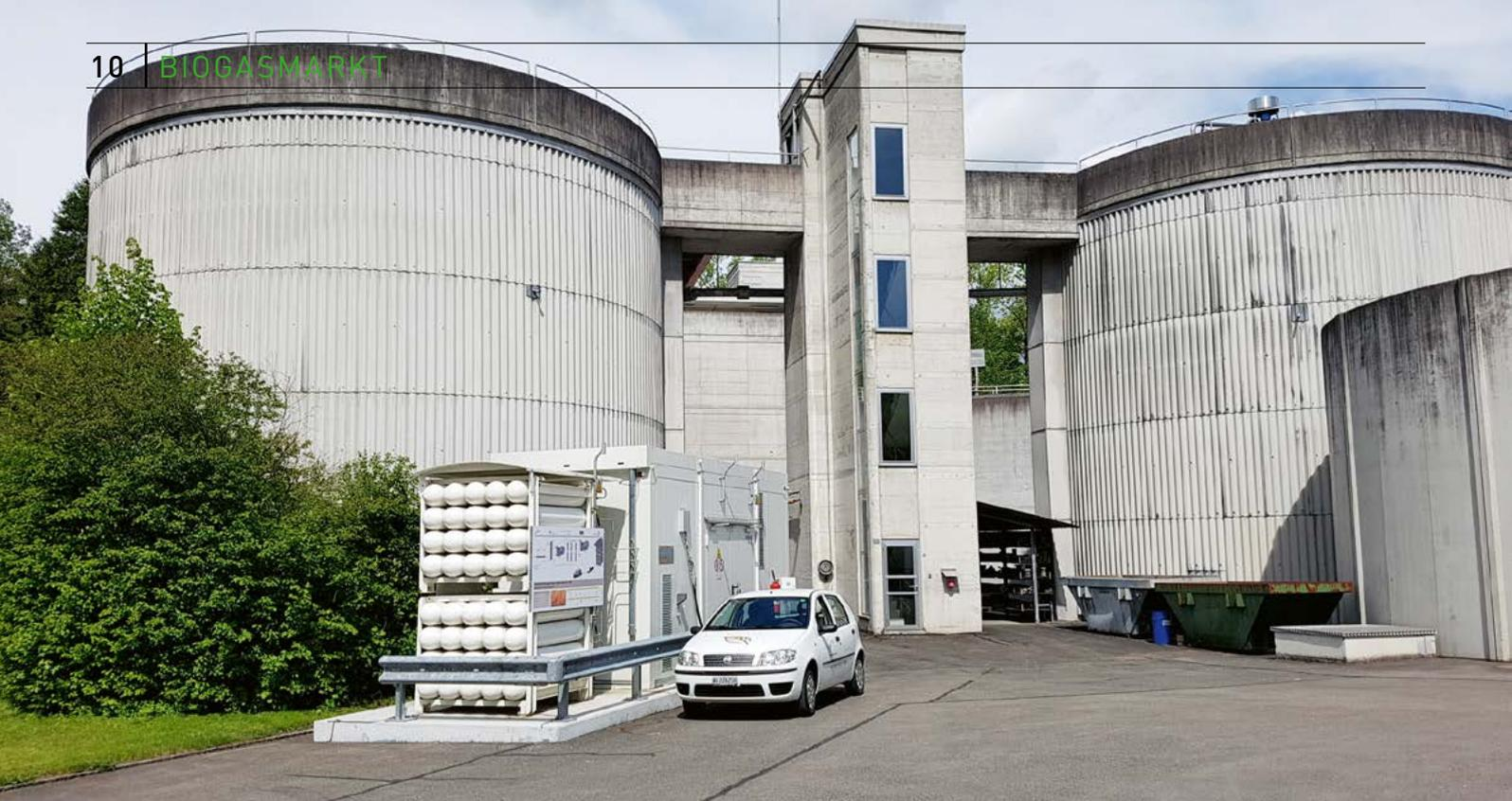
Treibstoff aus Klärgas: in Schönenwerd entsteht Biogas mit Erdgasqualität. Im Vordergrund die Speicherbündel. Im Hintergrund die Faultürme.
