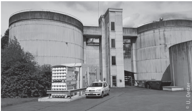
Treibstoff aus Klärgas: in Schönenwerd wird Biogas zu Erdgasqualität aufbereitet. Im Hintergrund die Faultürme, im Vordergrund die Anlage mit Technikcontainer und Speicherbündeln.
