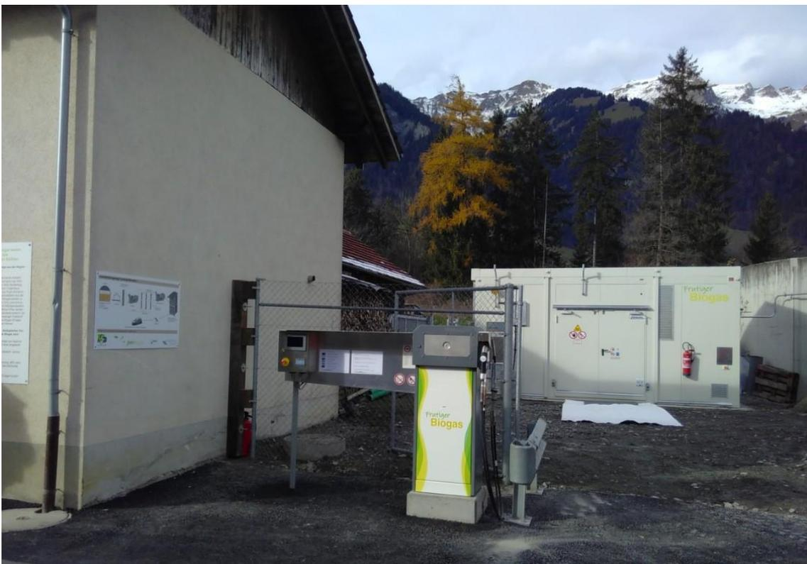
An dieser Zapfsäule kann rund um die Uhr Frutiger Biogas getankt werden. Im Hintergrund steht der Container, in dem das Biogas zu Treibstoffqualität aufbereitet wird.
